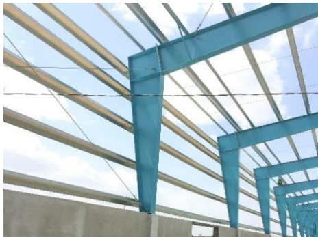
H形断面テーパ材を用いた架構例
